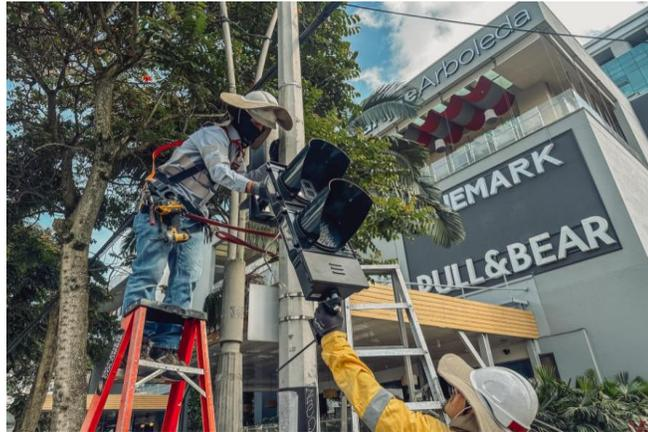
Ilustración 7. actividades semaforización instalación
